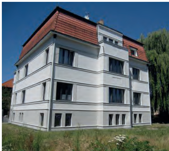
Sídlo Krizového centra na Jiráskově nábřeží č. 10
